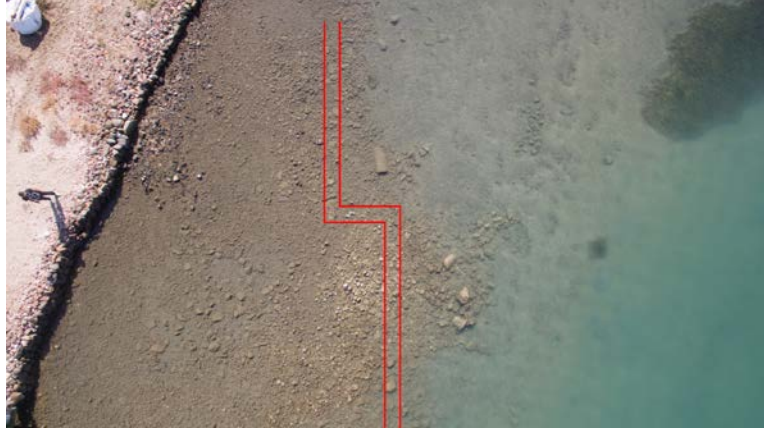
Fig. 7. Batı Kısmında Bulunan "L" Biçimli Duvar
