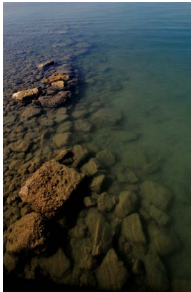
Fig. 9. Duvara Ait In Situ Blokların Genel Görünümü
