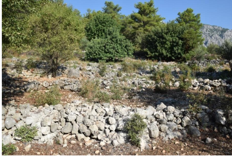
Fig. 8. Tahtalı Dağ'da tespit edilen paralel tipte antik teras yapıları
