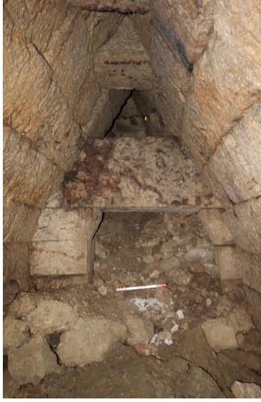
Fig. 16. C odası, kuzeyden güneye bakış, C odasıyla D odası arasındaki geçiş
