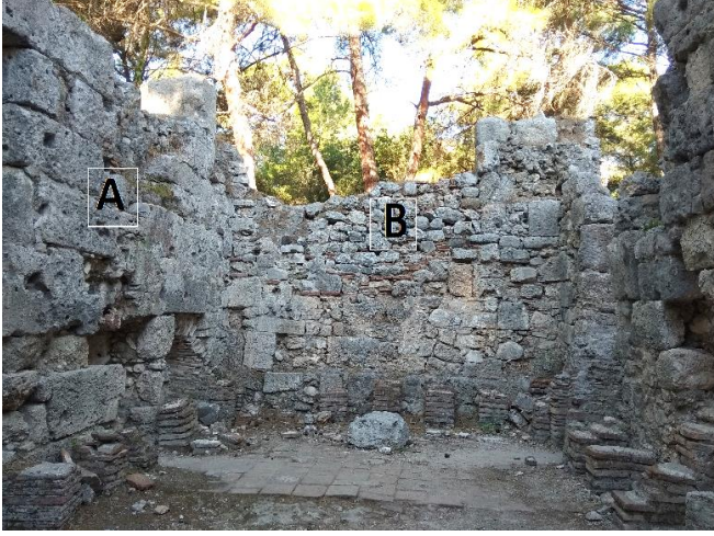
Fig. 2. Büyük Hamam 14 Nolu Mekan Yapı taşları
