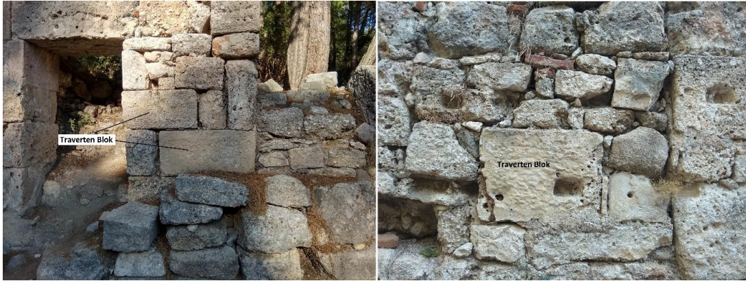
Fig. 4. Büyük Hamam'da Kullanılan Traverten Bloklar
