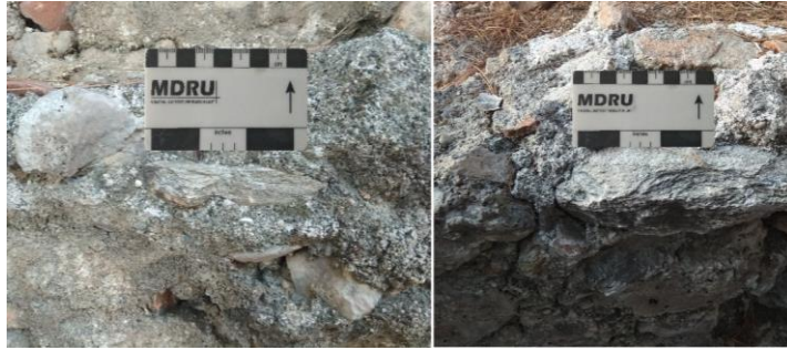
Fig. 33. 2M6 Hamamı Duvarında Kullanılan Şistler
