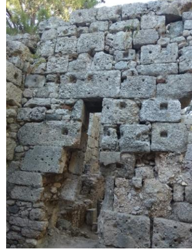
Fig. 3. Büyük Hamam 14 Nolu Mekanın Kuzey Duvarı
