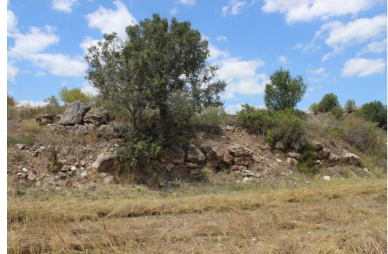
Fig. 9b. Üyük Mevkii Teras Duvarı
